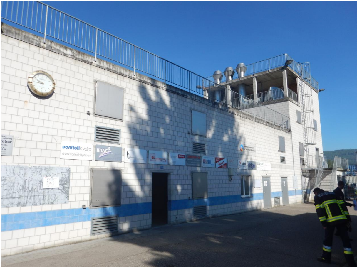
Brandhaus mit SPS Steuerung
